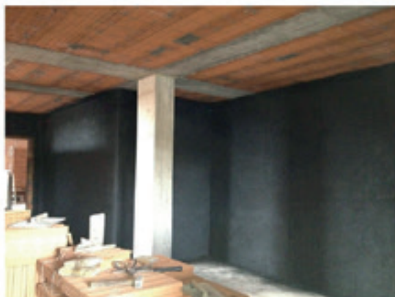
Wallrub - fabbricato in classe A - Venezia
