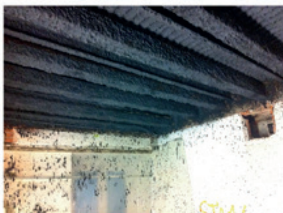
Wallrub - restauro via Monte Napoleone - Milano
