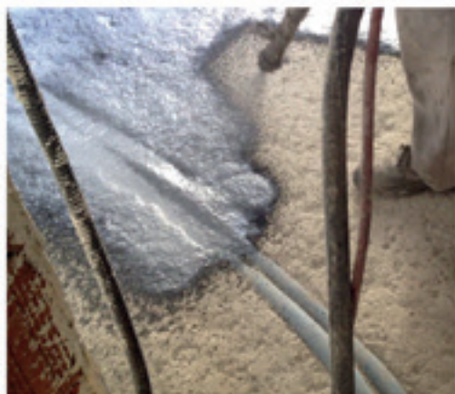
Floorub - fabbricato in classe A - Brescia
