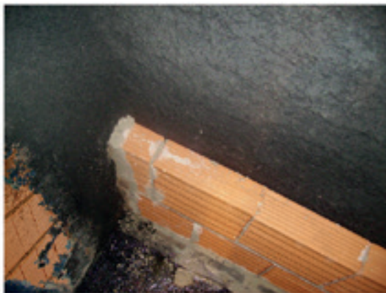
Wallrub, esempio di applicazione delle strisce per la desolidarizzazione delle partizioni verticali.
