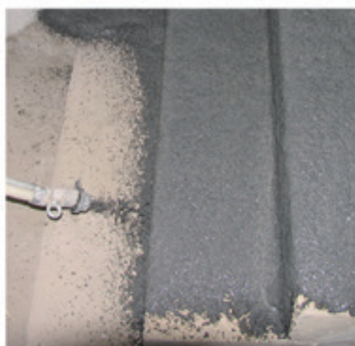
Floorub - rivestimento scale - Firenze
