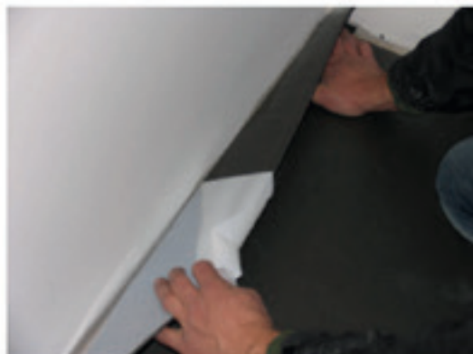
4 - Rimuovere la pellicola protettiva nella parte alta della fascia Latomuro .
