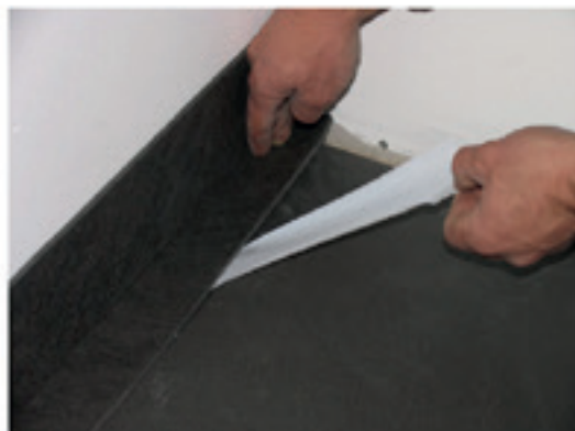
6 - Rimuovere la pellicola inferiore e premere accuratamente la fascia Latomuro sul materassino.
