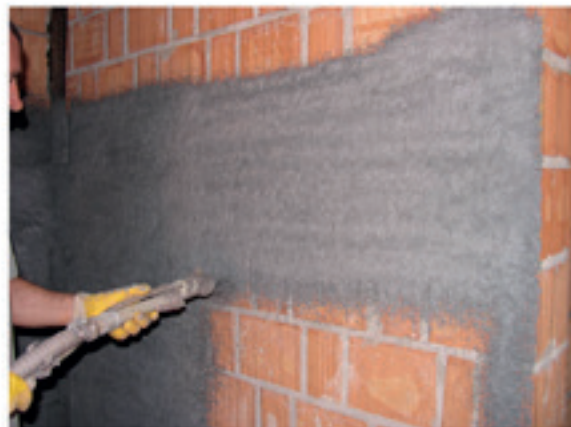
Wallrub, esempio di applicazione su pareti in laterizio per l'isolamento acustico dai rumori aerei.
